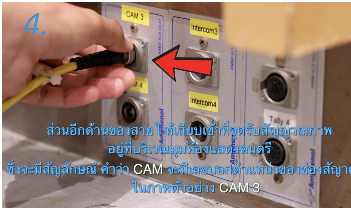
ภาพที่ 17 การเชื่อมสัญญาณภาพกับ Switchers รูปที่ 4
